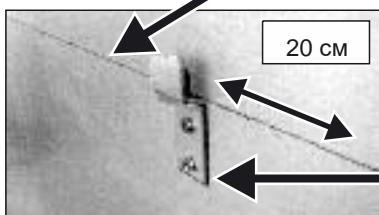
Отодвинуть ванну и приступить к монтажу фиксирующих пластин. Сделать отверстия в стене диаметром 6 мм. Вставить дюбеля и при помощи с морозов закрепить пластины.
