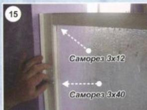
Выставить профиль по стене и закрепить его к ней саморезом 3x40.
