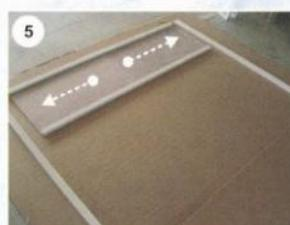
Неподвижную створку вставить между дугами, обработав предварительно пазы герметиком.
