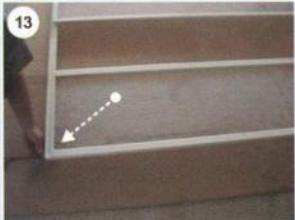
Установить вторую неподвижную часть в пазы обработанные герметиком и закрепить её саморезами 3,5x40 через отверстия в направляющем профиле
